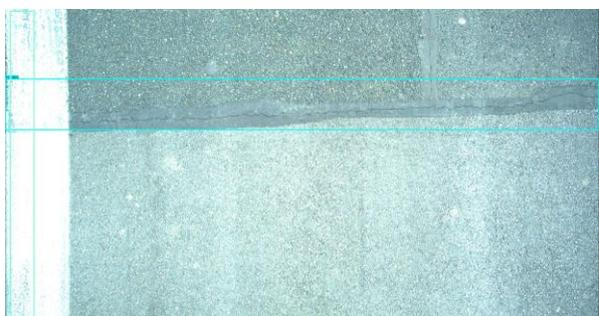
*Détection erronée de dégradations (dans marquage)*
