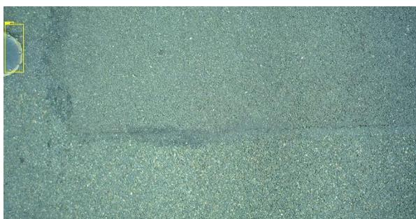
*Détection erronée de dégradation (confusion avec dispositif lumineux)*
