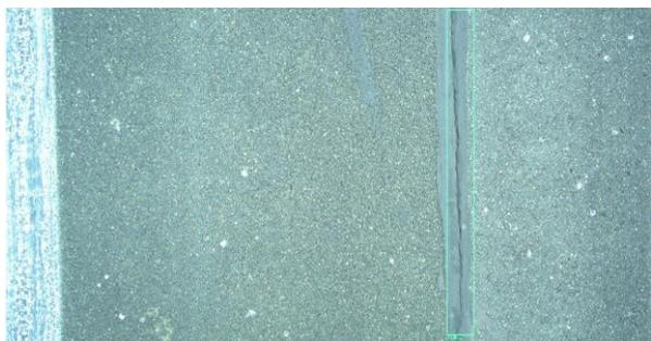
*Détection exacte de dégradations (fissure prononcée)*
