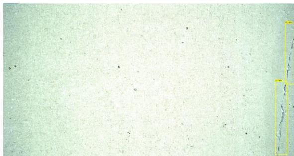
*Détections exactes de dégradations (fissures multiples)*
