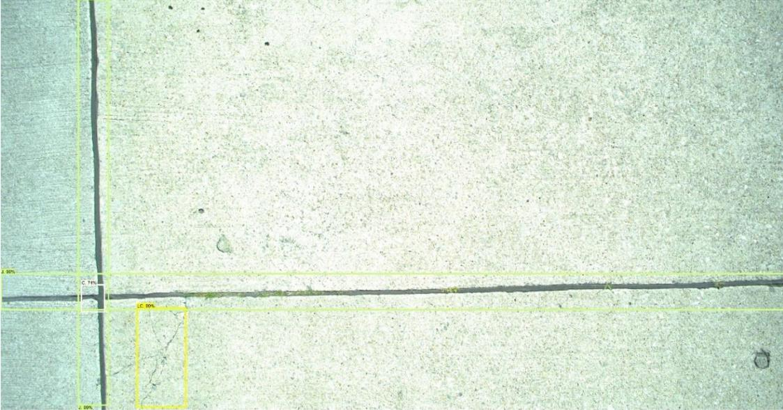
Figure 21. Détection d'une fissure à proximité d'un coin de dalle
