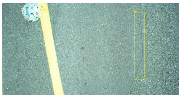
*Détection erronée de dégradation (bordure de réparation)*
