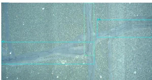
*Détections exactes des dégradations (fissures multiples)*
