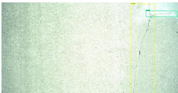
*Détections exactes des dégradations et du joint*
