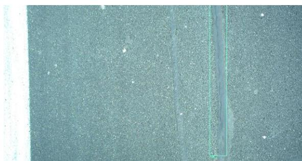
*Détection exacte de dégradations (fissure fine)*
