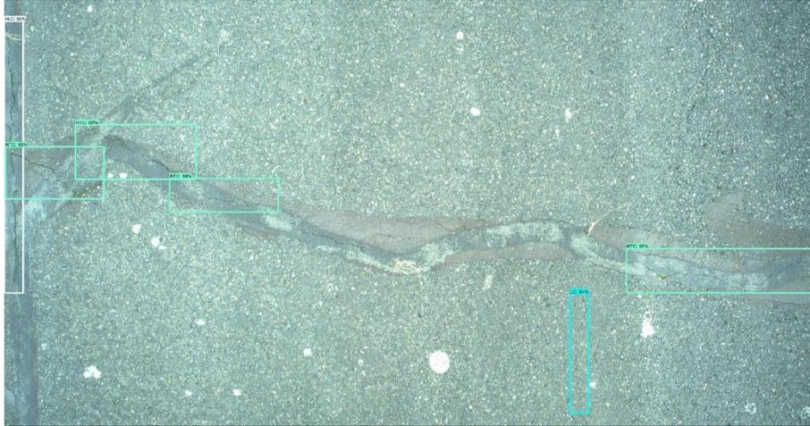
Figure 16. Exemple de détections des classes RLC et RTC (dégradations situées dans des pontages)
