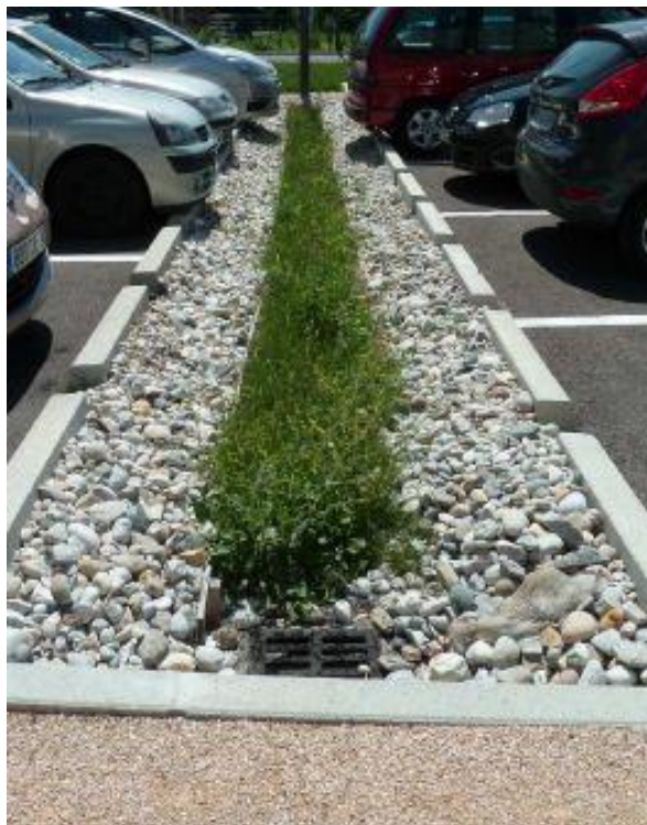
Figure 20 : photo d’une tranchée drainante (Cerema)
