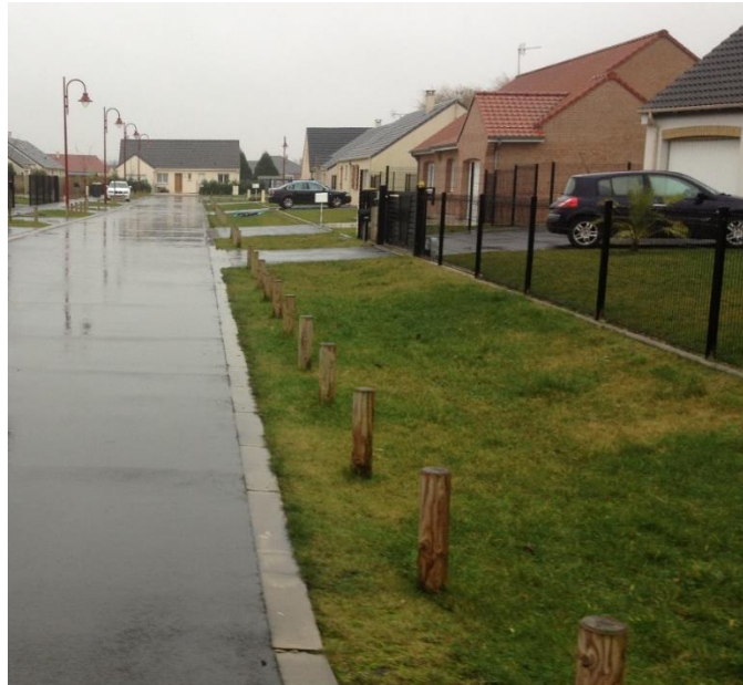
Figure 16 : photo d'une noue à Evin-Malmaison (Cerema)
