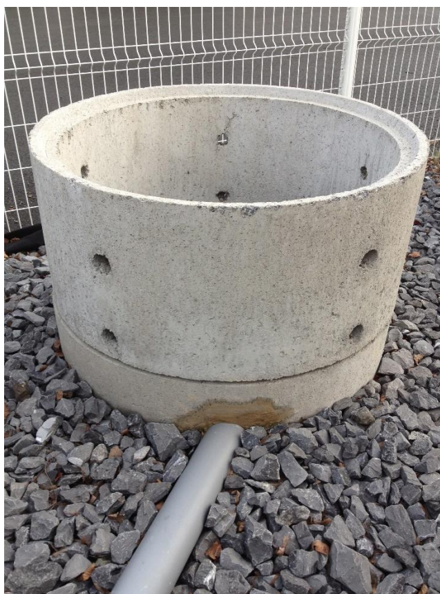
Figure 22 : photo d'un puit équipé d'éléments préfabriqués perforés (Cerema)
