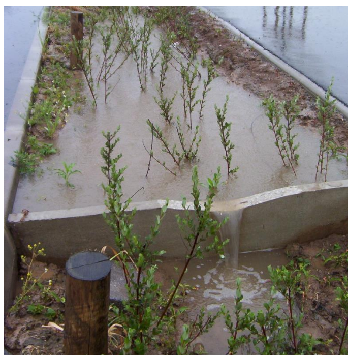
Figure 19 : photo d'une noue avec cloison (Cerema)
