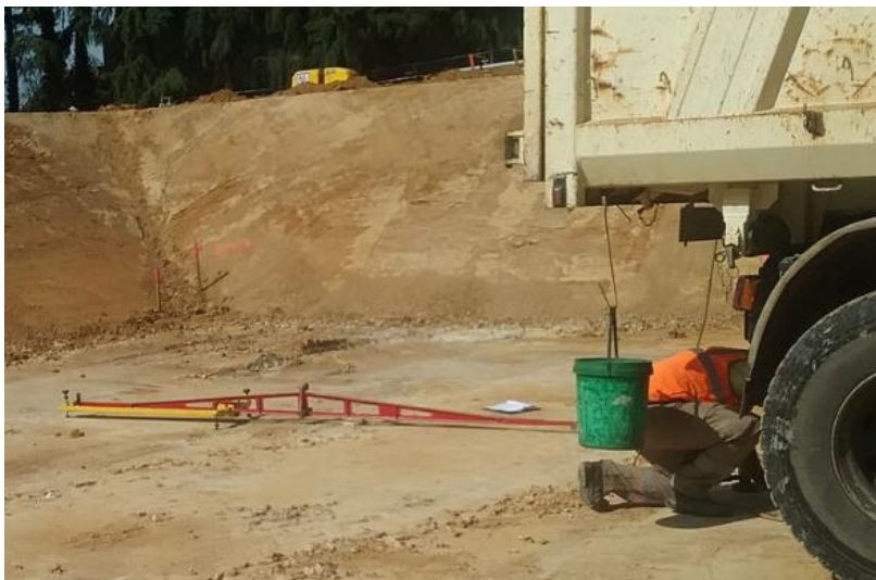
Figure 2 : conditions de chantier pour la mesure de déflexion à la poutre Benkelman
