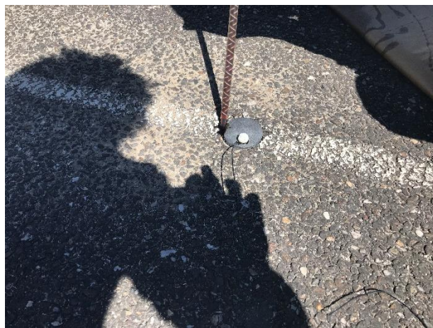
Figure 5 : Scellement du capteur
