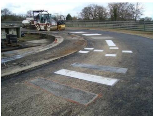
Figure 1. Mise en place des défauts de collage entre couches d'enrobés sur le manège de fatigue de l'IFSTTAR
