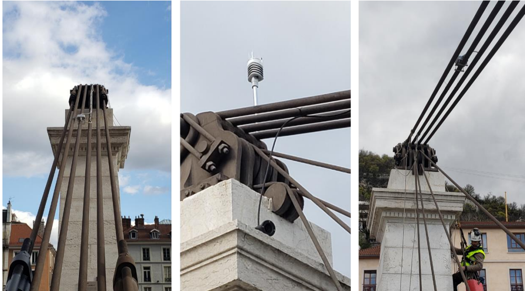
Figure 8 : Fixation de la station météo, de la caméra de comptage et des nœuds de mesure sur les haubans.
